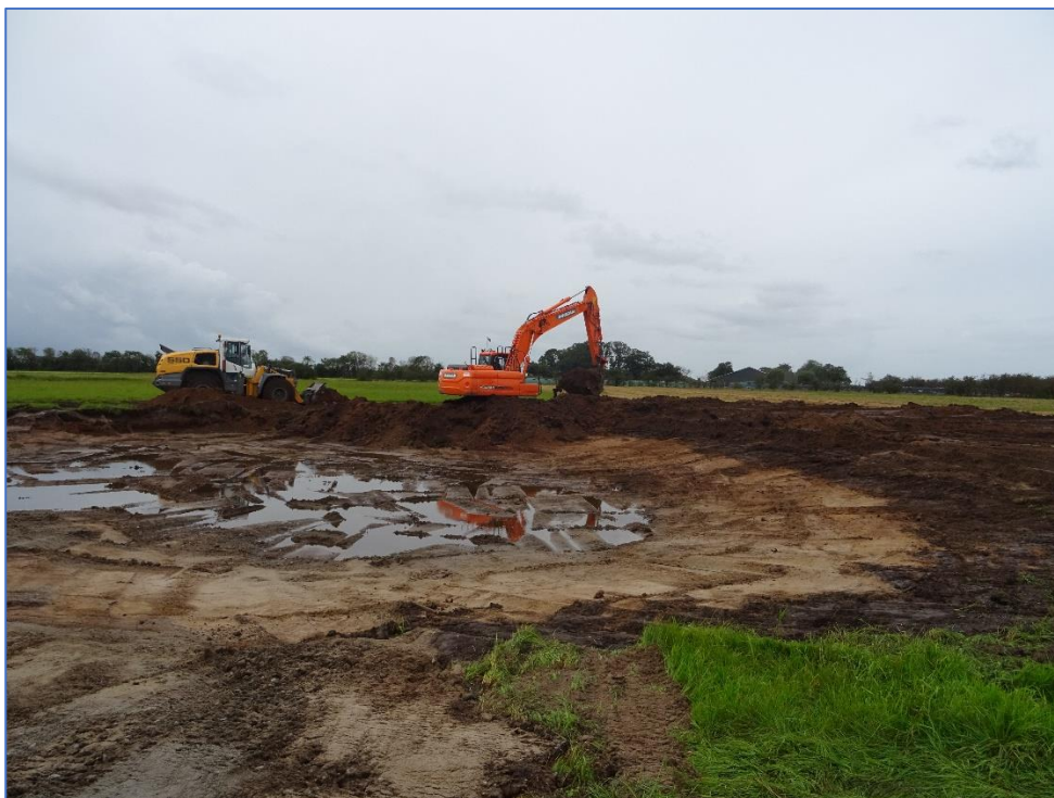
Ny sø i område 2 anlægges, efterår 2019
